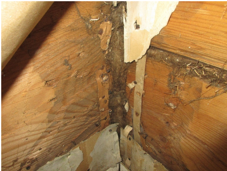
Kuva 14. Rakenneavaus RA8 lähempää kuvattuna.
