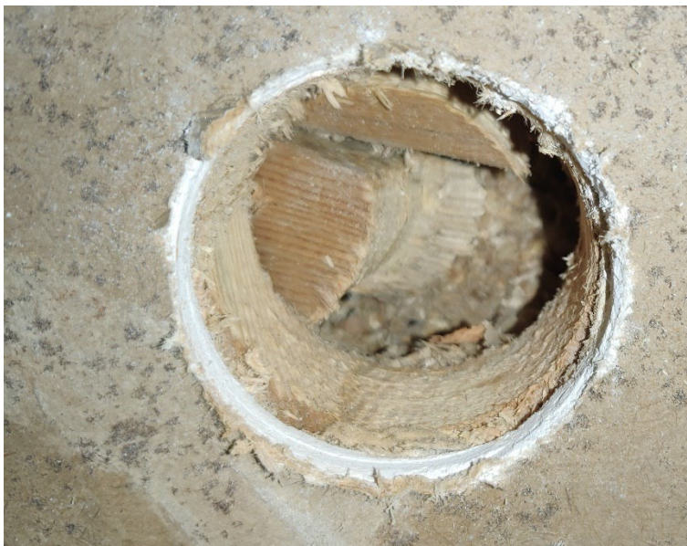
Kuva 10. Rakenneavaus RA6 lähempää kuvattuna.
