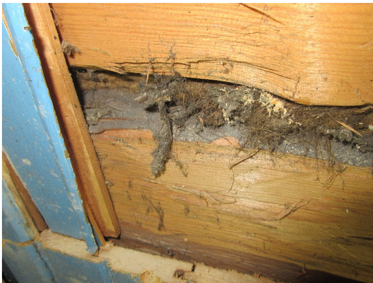
Kuva 3. Rakenneavaus RA2 lähempää kuvattuna.
