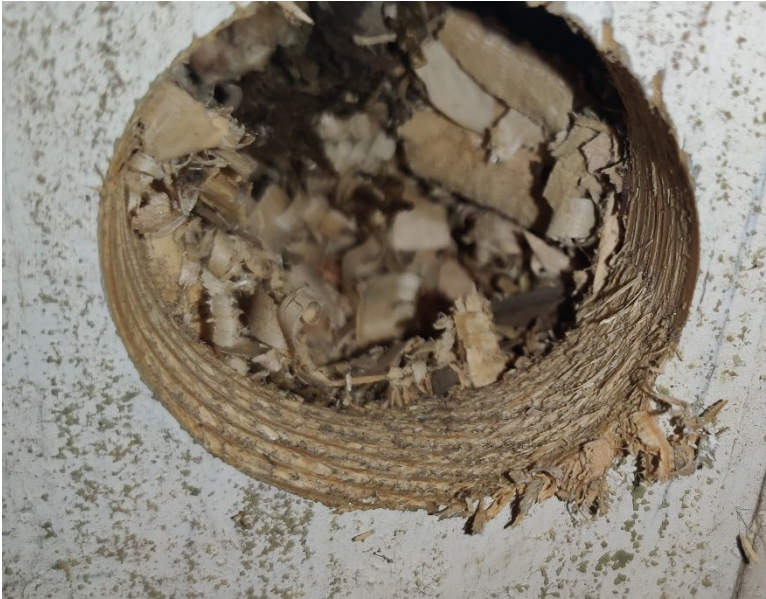
Kuva 12. Rakenneavaus RA7 lähempää kuvattuna.
