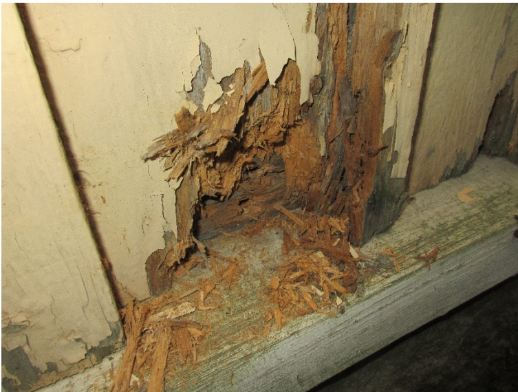
Kuva 17. Rakenneavaus RA10. lähempää kuvattuna.
