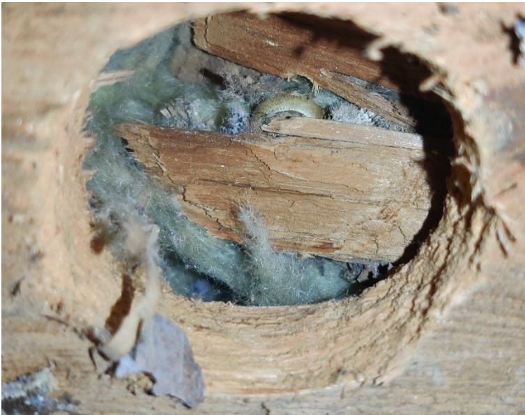
Kuva 8. Rakenneavaus RA5 lähempää kuvattuna.
