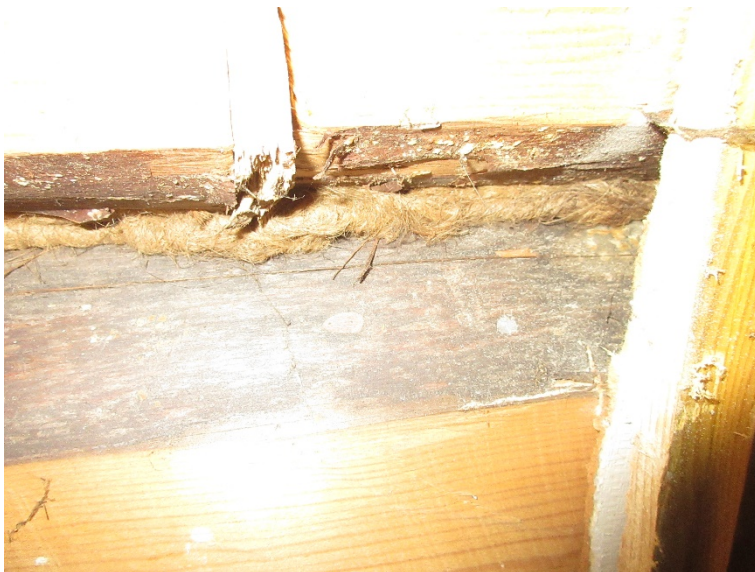
Kuva 5. Rakenneavaus RA3 lähempää kuvattuna.
